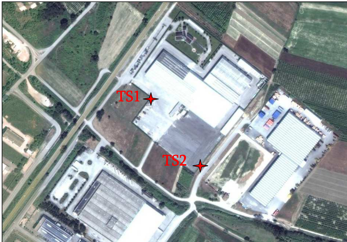
Fig. 9 – Ubicazione dei punti di prelievo dei campioni di terreno all'interno del lotto.
