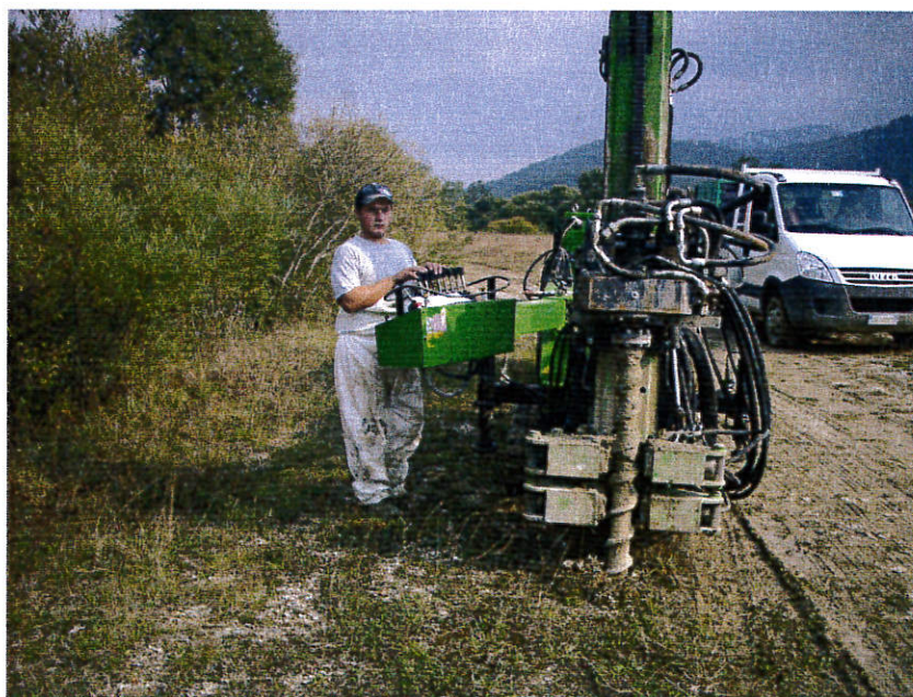
Foto n°6 – Postazione sondaggio geognostico S1.
