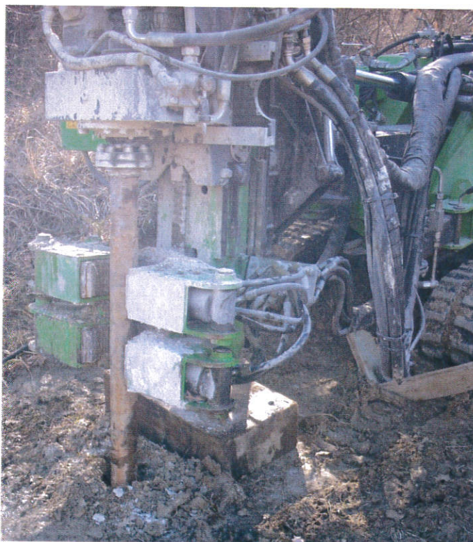
Foto n°9 – Particolare del sondaggio geognostico S3.
