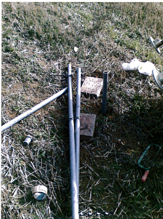
Foto n°5 – Installazione piezometri.
