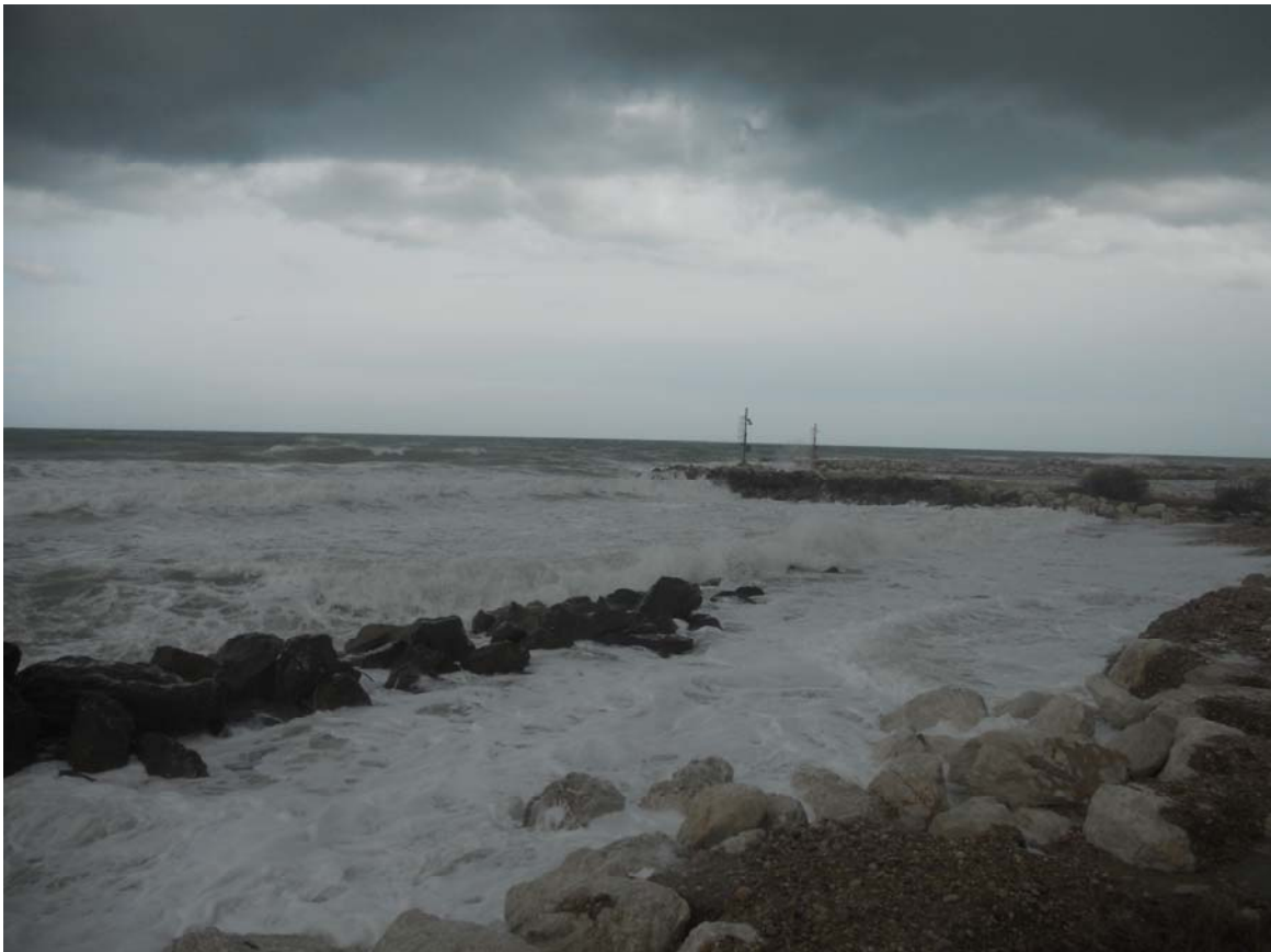
Foto 2 – Barriera radente da ricostituire
