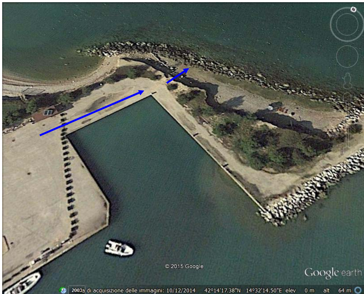
Foto 3 - Porto Turistico "Marina del Sole" Area di Cantiere n.1
