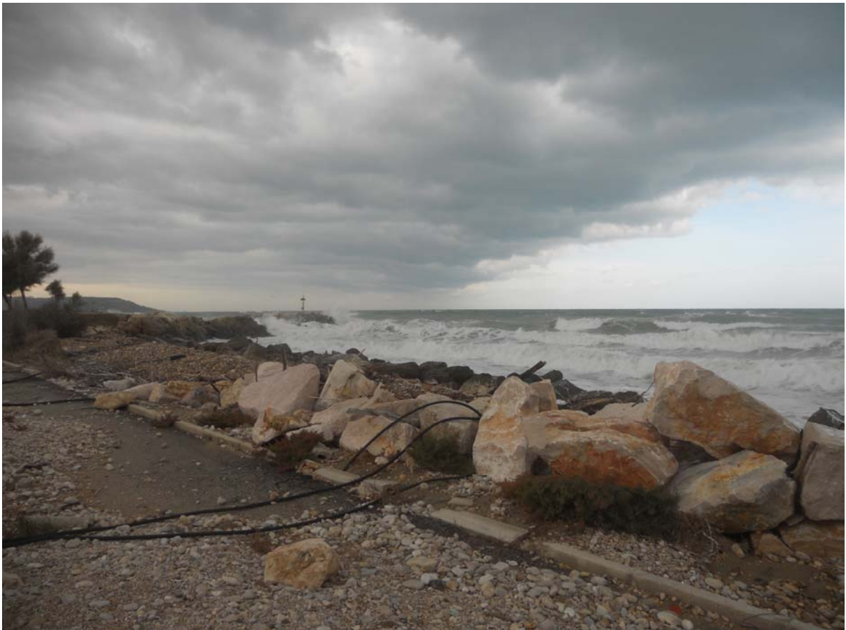
Foto 1 - Barriera radente da ricostruire
