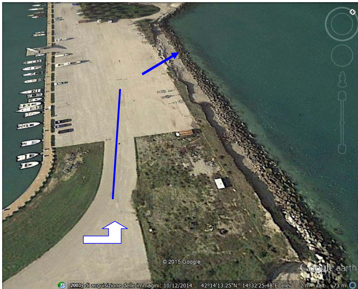
Foto 5 - Porto Turistico "Marina del Sole" Area di Cantiere n.2
