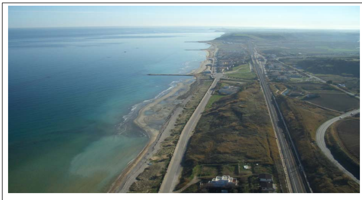
Area di intervento: dalla zona del primo pennello a sud dello stesso
