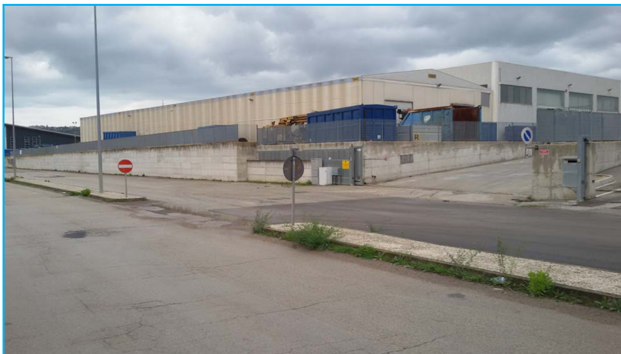
Fig. 14 - CAPANNONI – Vista dall'esterno, dall'ingresso n. 1
