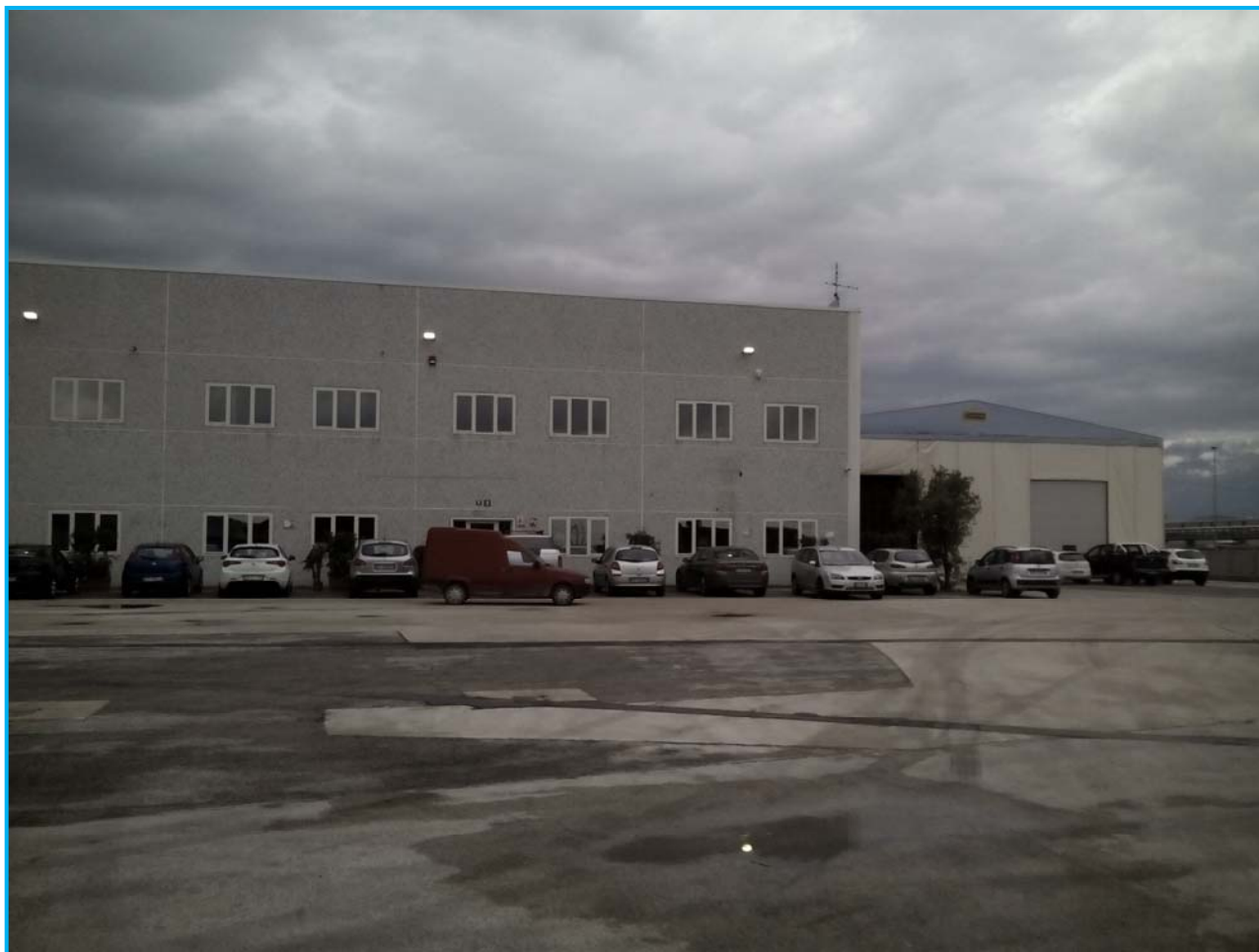
Fig. 14 - CAPANNONI – Vista dall'interno, dal lotto N. 3
