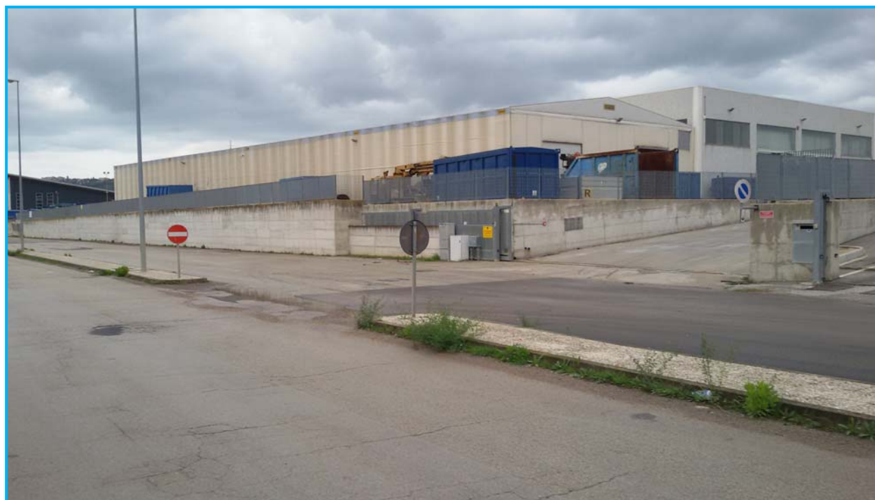
Fig. 14 - CAPANNONI – Vista dall'esterno, dall'ingresso n. 1
