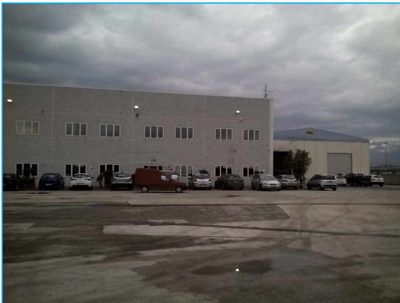
Fig. 14 - CAPANNONI – Vista dall'interno, dal lotto N. 3
