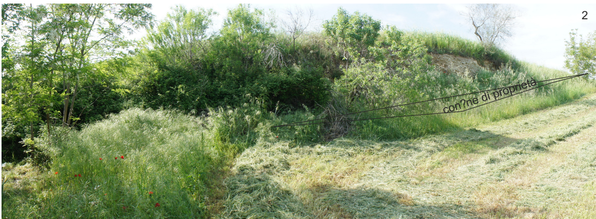
Particolare del con?ne a scarpata arti?ciale che sarà eliminato al termine dei lavori
