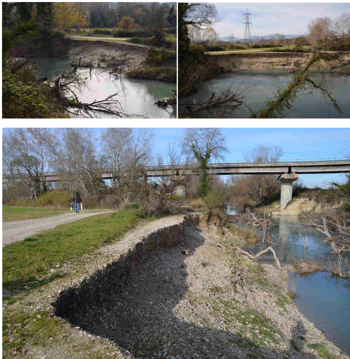
Intervento 4: Fenomeni di erosione della sponda sinistra del fiume Pescara
