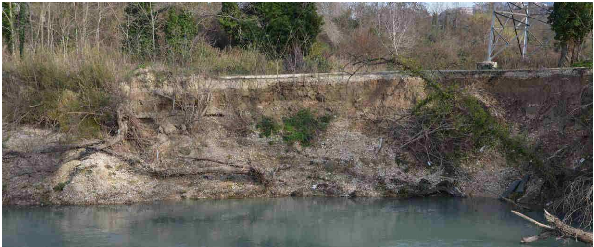
Intervento 4: Fenomeni di erosione della sponda destra del fiume Pescara
