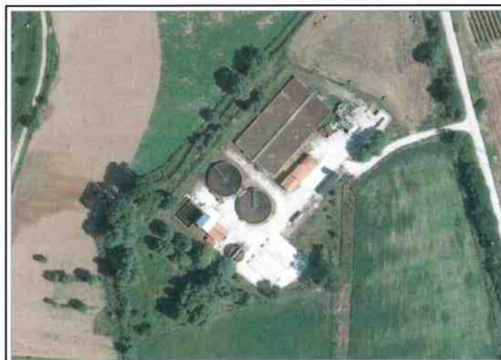
Fig. 2 – Stato dell'arte dell'impianto – foto aerea del 2011 (da fig. 2 contenuta nello SPA)
