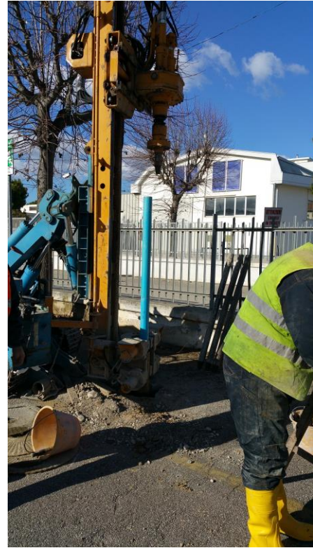
Inserimento tubo piezometrico nel sondaggio S1
