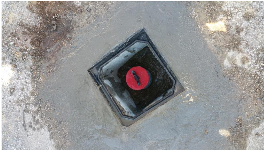
Cementazione testa del piezometro
