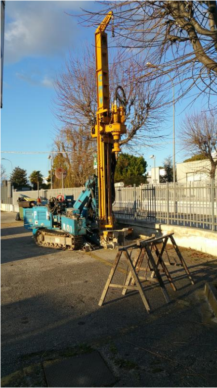
Postazione del sondaggio S1
