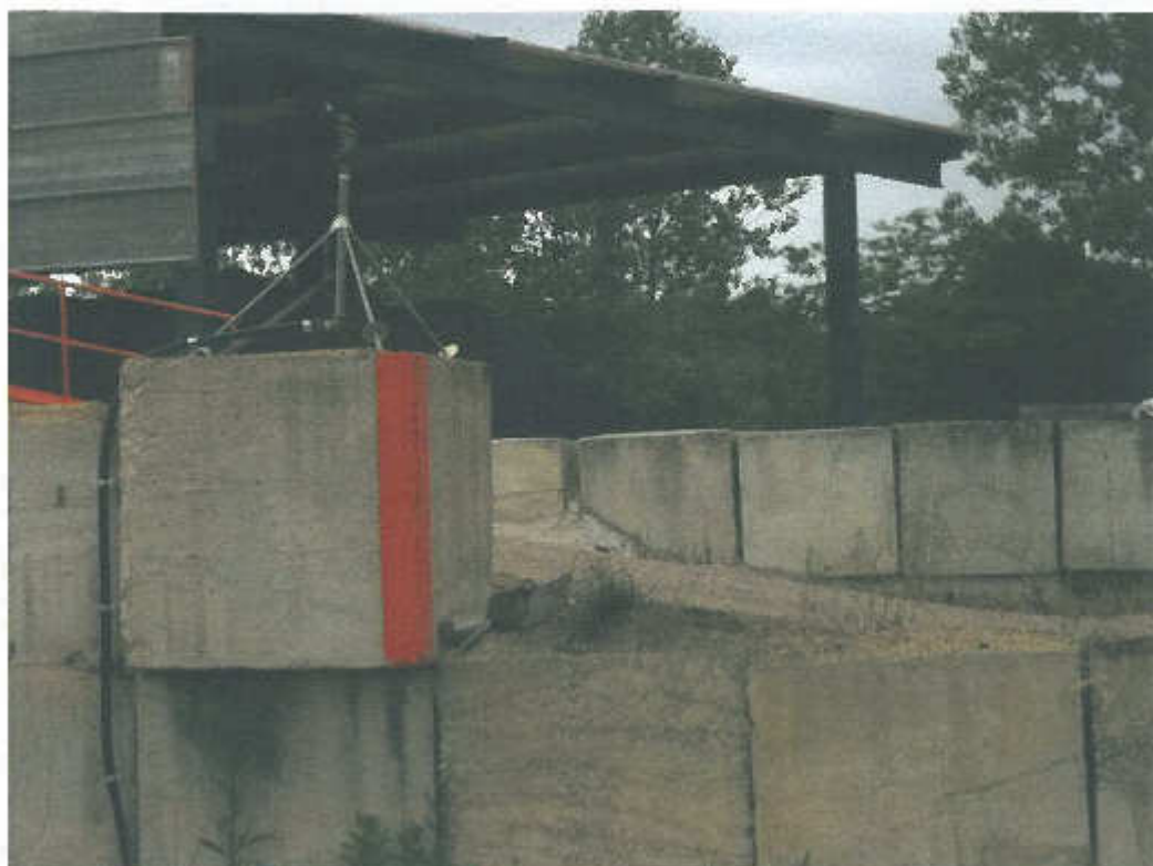
Uno degli ugelli per l'umidificazione del fondo, lungo la pista percorsa dai mezzi che movimentano i rifiuti/MPS.
