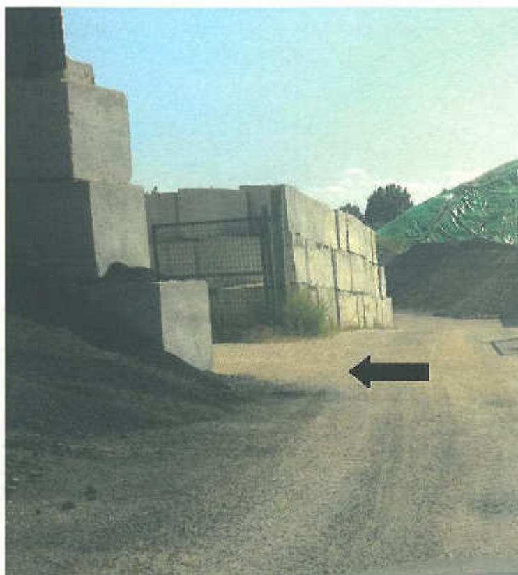
Cancello e recinzione in blocchi di cls dell'impianto di gestione rifiuti. Punto di accesso. Il fondo è pavimentato, anche per la strada di accesso.
