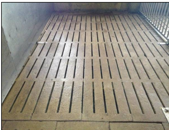
Figura 59-Pavimento totalmente fessurato
