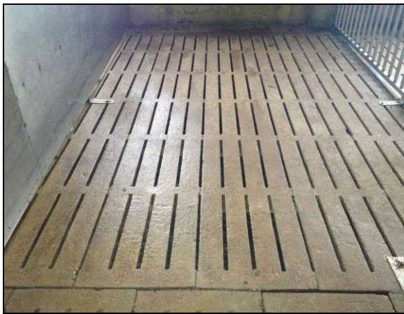
Figura 3.1 Pavimento totalmente fessurato
