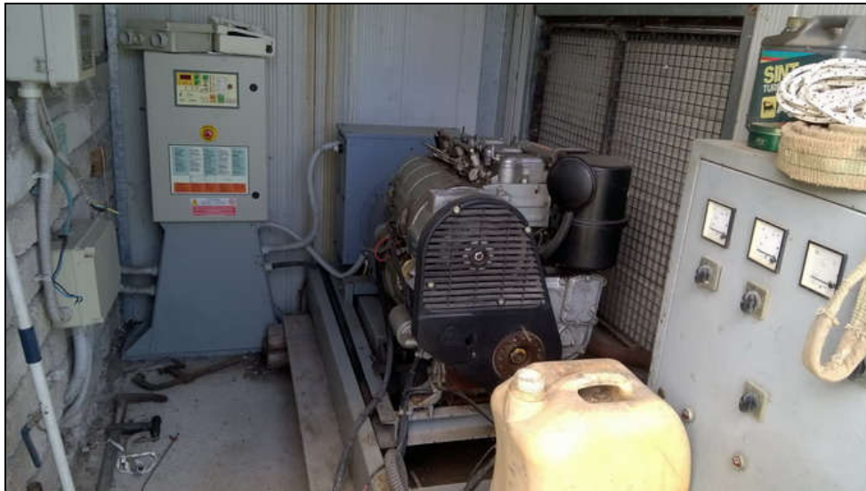
Figura 7.1 Gruppo elettrogeno d'emergenza alimentato a gasolio
