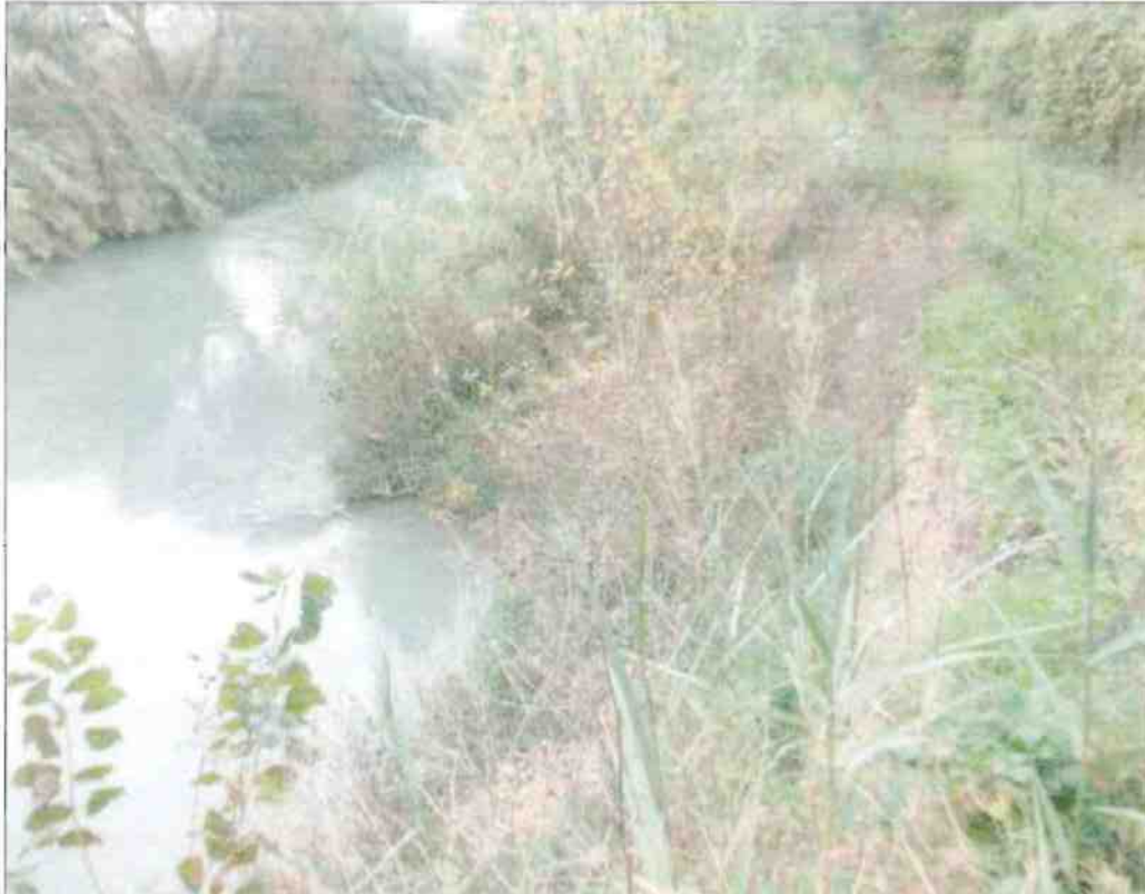
Figura 4- erosione della sponda destra con eccessiva vegetazione e accumuli di materiale di piena nell'alveo del fiume;
