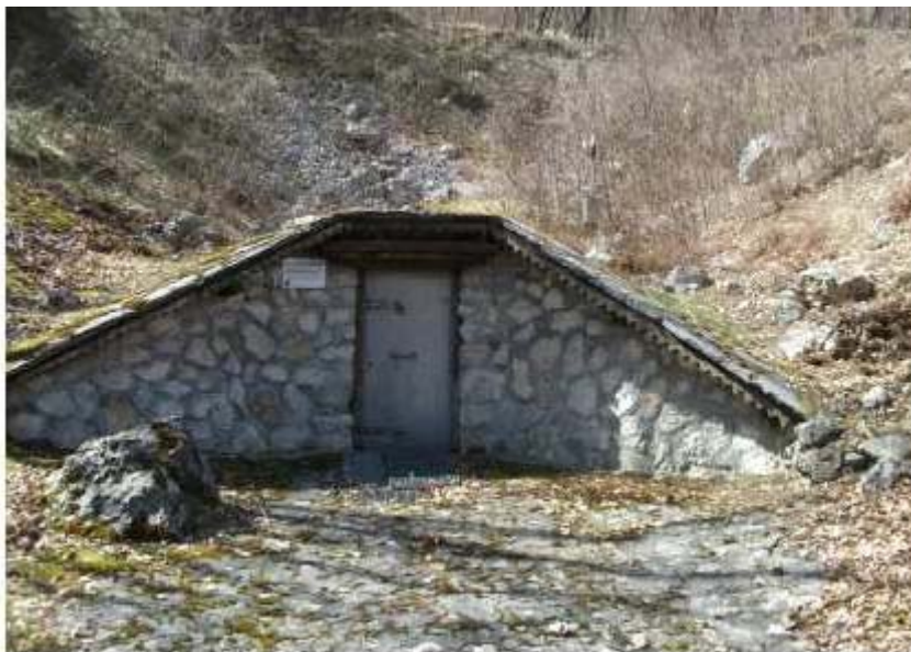
Figura 4 – Ripresa fotografica della struttura muraria esterna del bottino di presa della concessione mineraria "Sant'Antonio Sponga".
