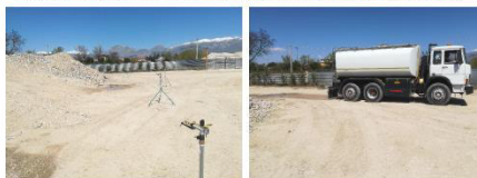
Sistemi di bagnatura amovibili in prossimità dell'area materie prime certificate
