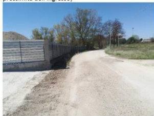
Barriera vista dall'esterno sul lato nord dell'impianto in prossimità dell'ingresso
