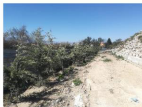
Barriera visiva e acustica lato sud impianto (in prossimità dell'area di stoccaggio rifiuti)
