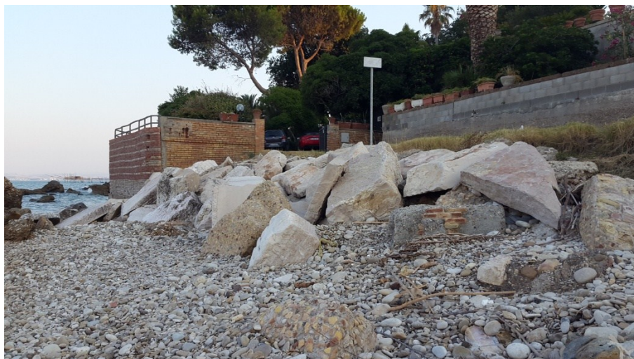
Vista del tratto a sud con intervento di protezione eseguito
