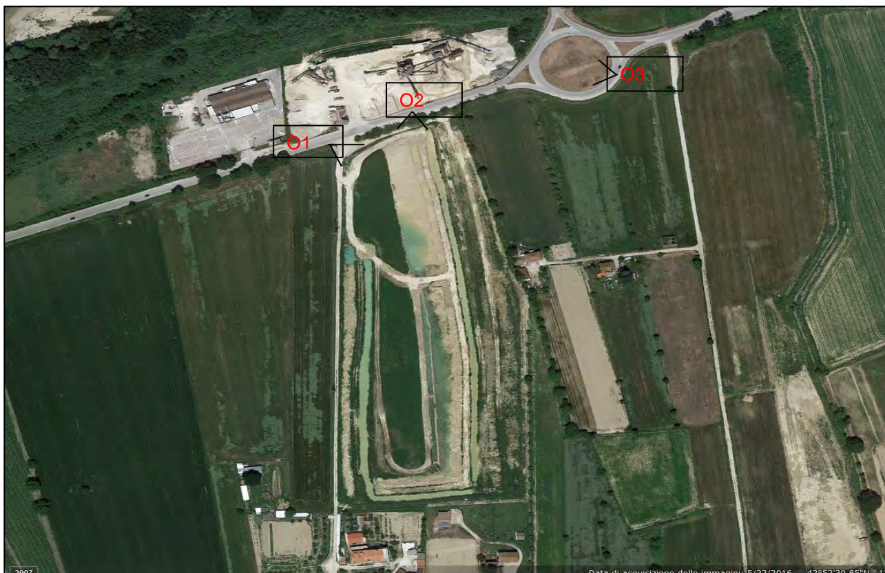
Fig. 75: Ubicazione impianto con punti di ripresa fotografica - base ortofoto
