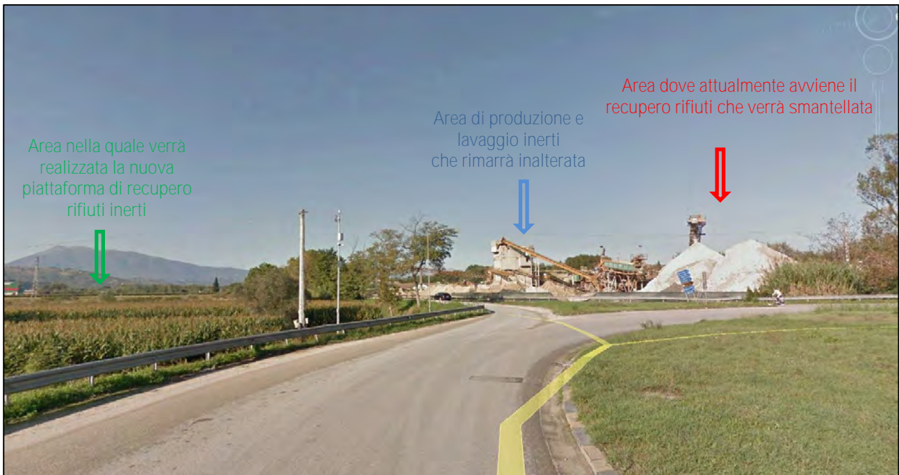
Fig. 78: Visuale fotografica dal pt.03- fonte: Google Street View
