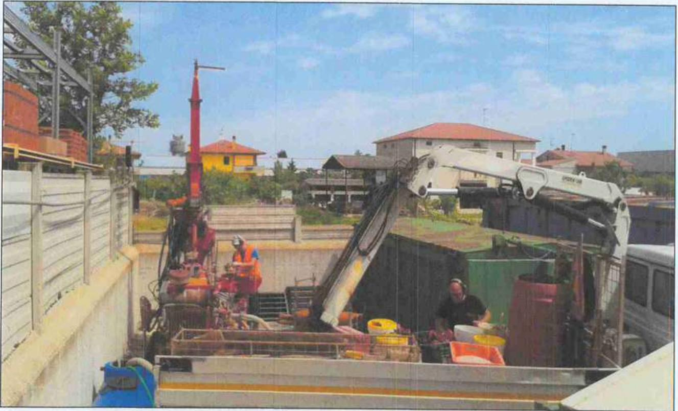
Foto 2 - Realizzazione del sondaggio S1.
