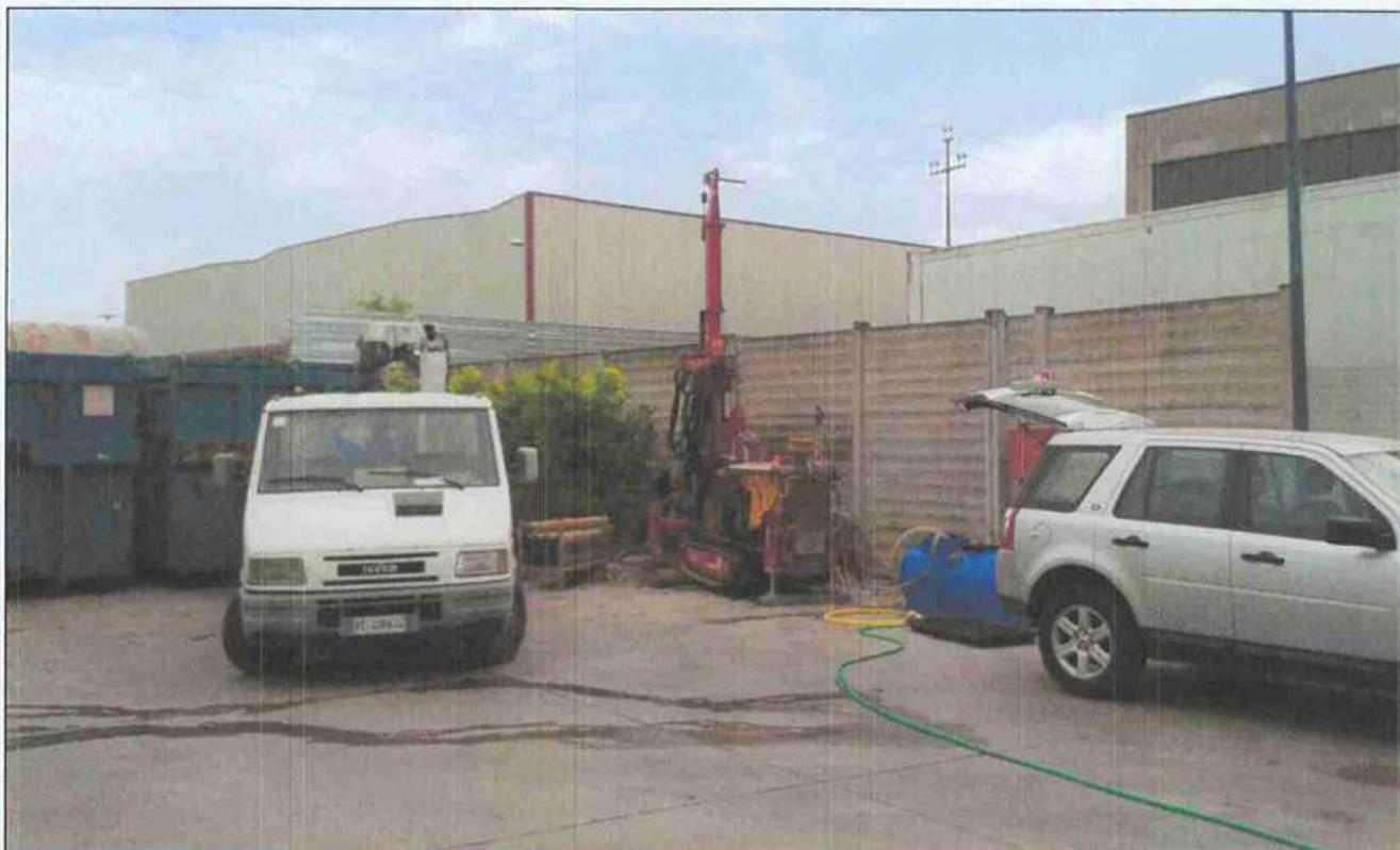
Foto 8 - Realizzazione del sondaggio S3.
