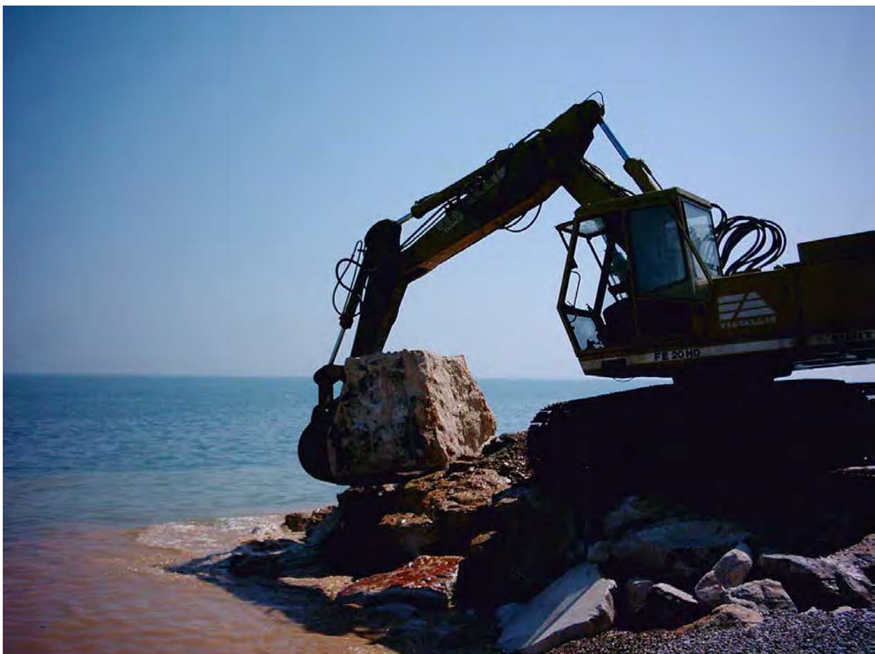
Fig. 5 - Escavatore meccanico cingolato intento a movimentare gli scogli.
