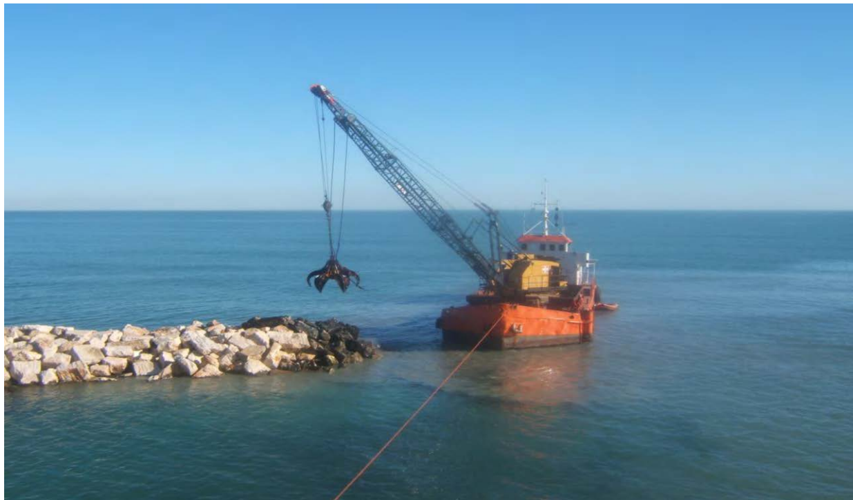
Fig. 6 - Motopontone all'opera con gru a grappo per la movimentazione e posa in opera dei massi.
