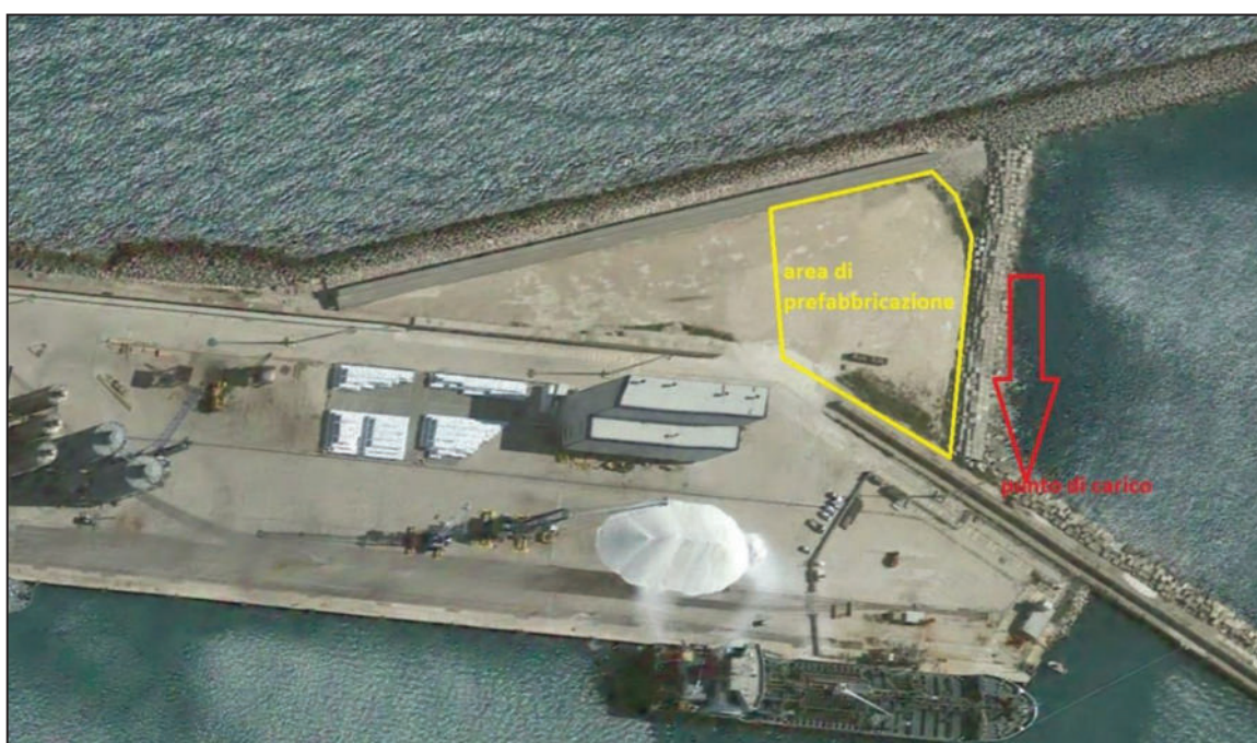
Figura 1 – area di prefabbricazione tetrapodi nel Porto di Ortona
