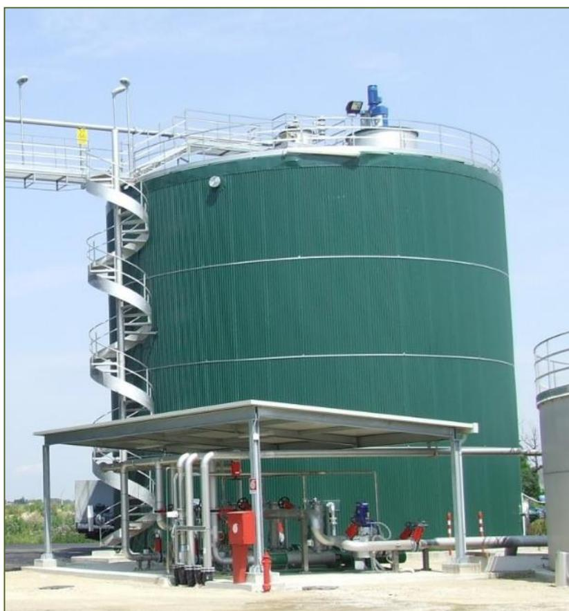
Serbatoio di stoccaggio ed Idrolisi
