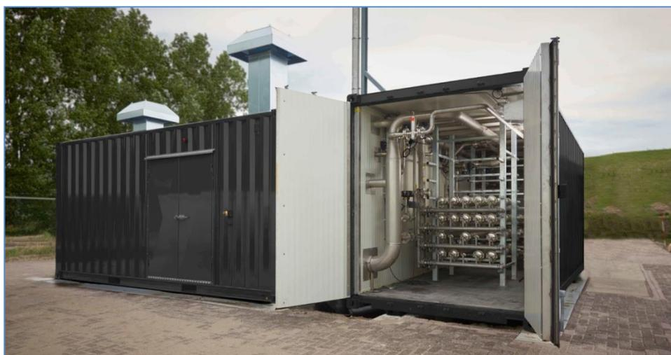
Container impianto di Upgrading biogas
