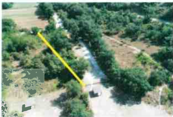
Foto n. 1: panoramica aerea dell’Area di studio n. 1 con indicazione del tracciato in variante
