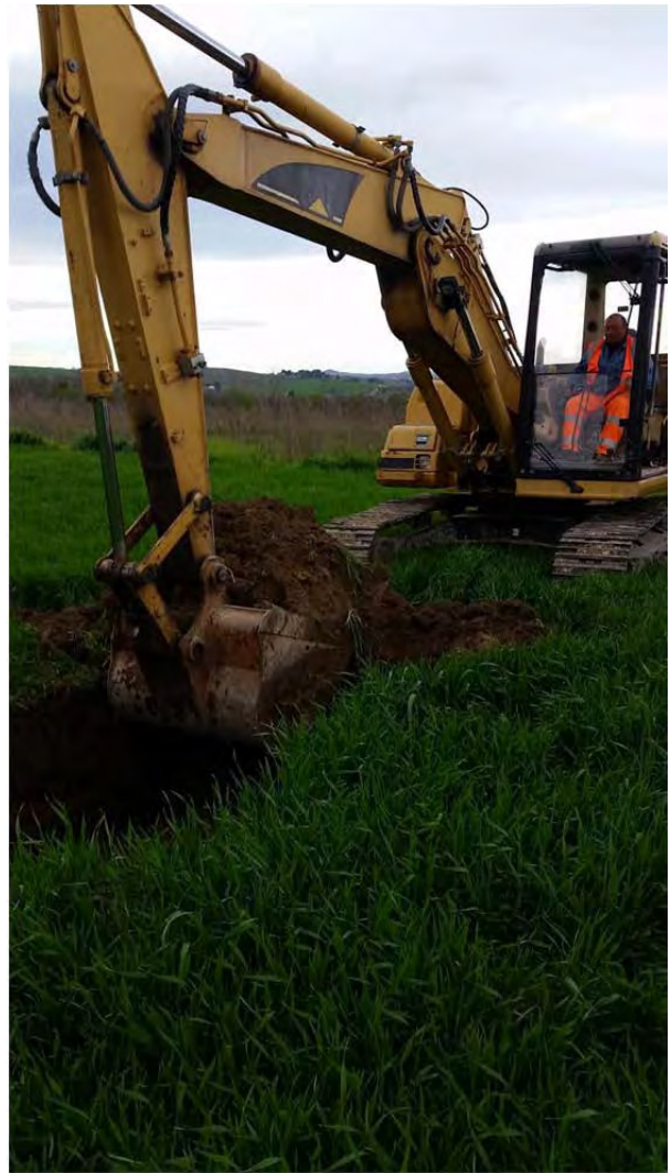
Particolare trincea geognostica T2
