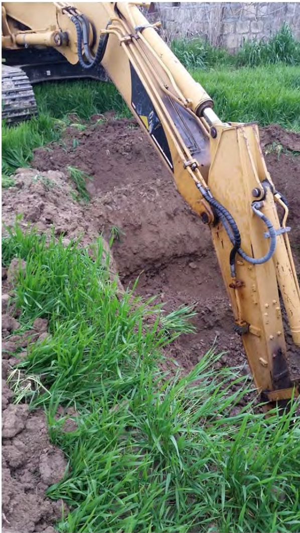
Particolare trincea geognostica T1
