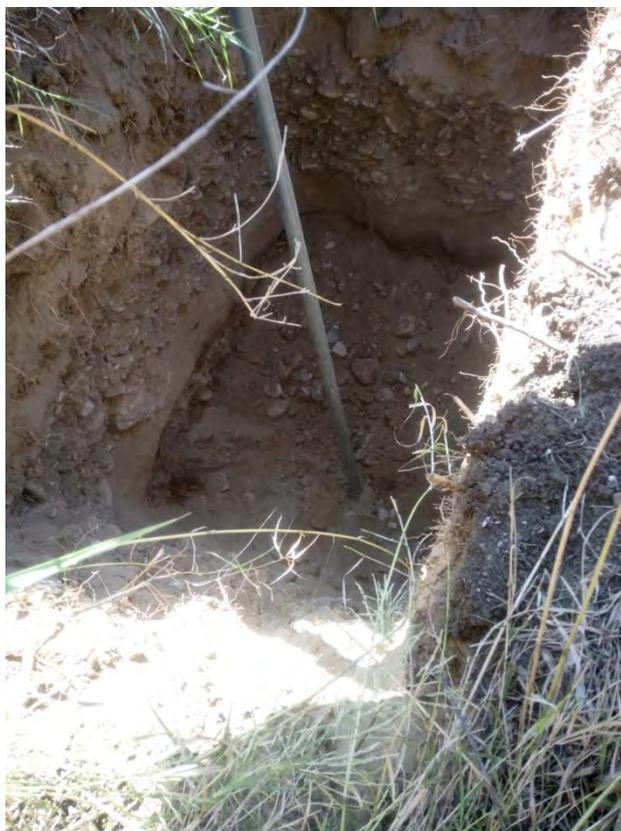
Fig. n.2 – Fase di scavo trincea per installazione piezometro.
