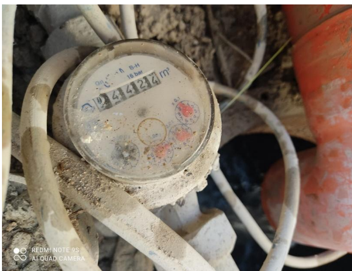
Contatore per contabilizzazione consumi di acqua per abbattimento polveri
