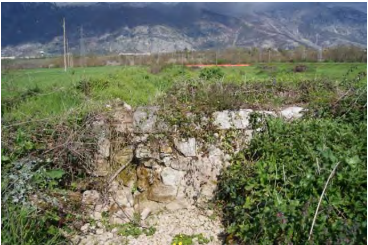
Fig. 14 - Particolare di uno dei tanti anelli realizzati in blocchi litici sbozzati (campi nn. 5 e 6)
