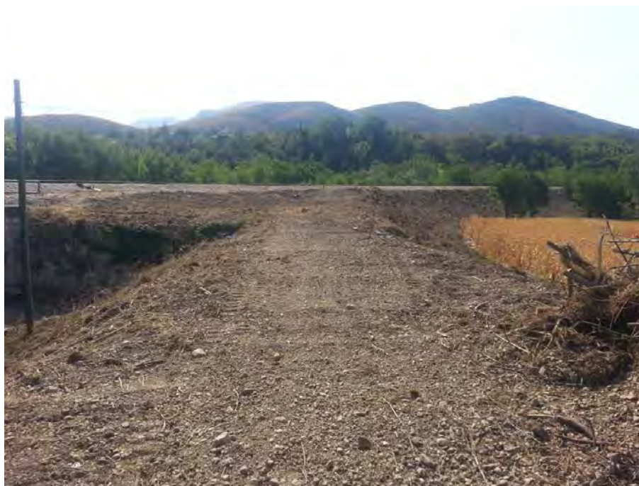
Fig8 presunto terrapieno ferroviario che si innesta sull'esistente
