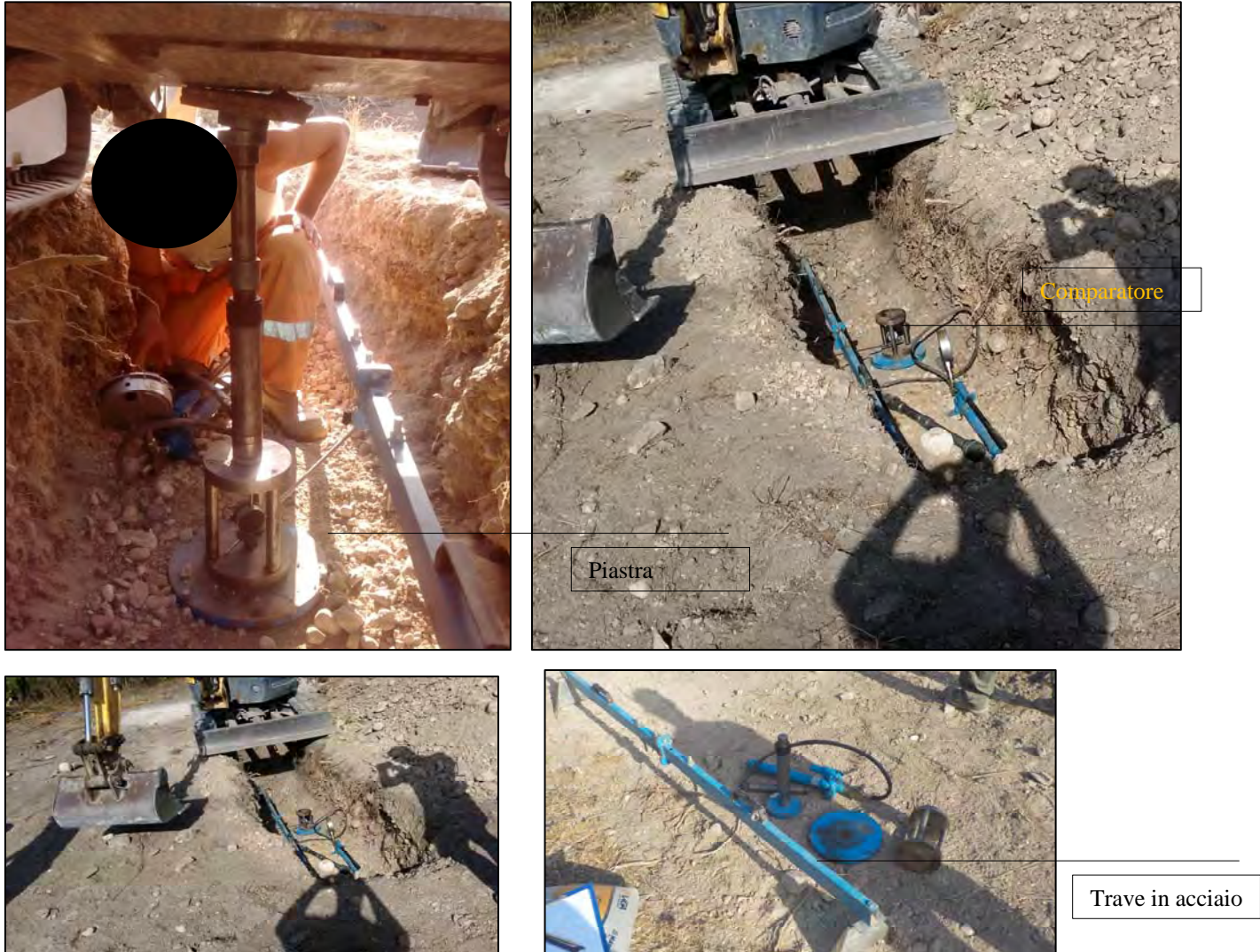
Fig. 10: Fasi di esecuzione prove di carico su piastra.
