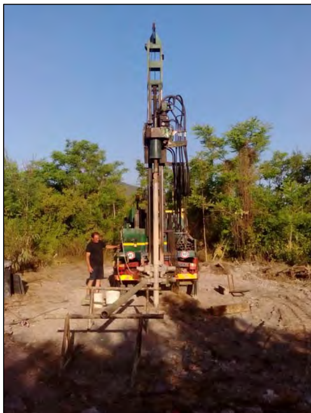
Fig.1 Impianto di perforazione su uno dei punti di indagine.
