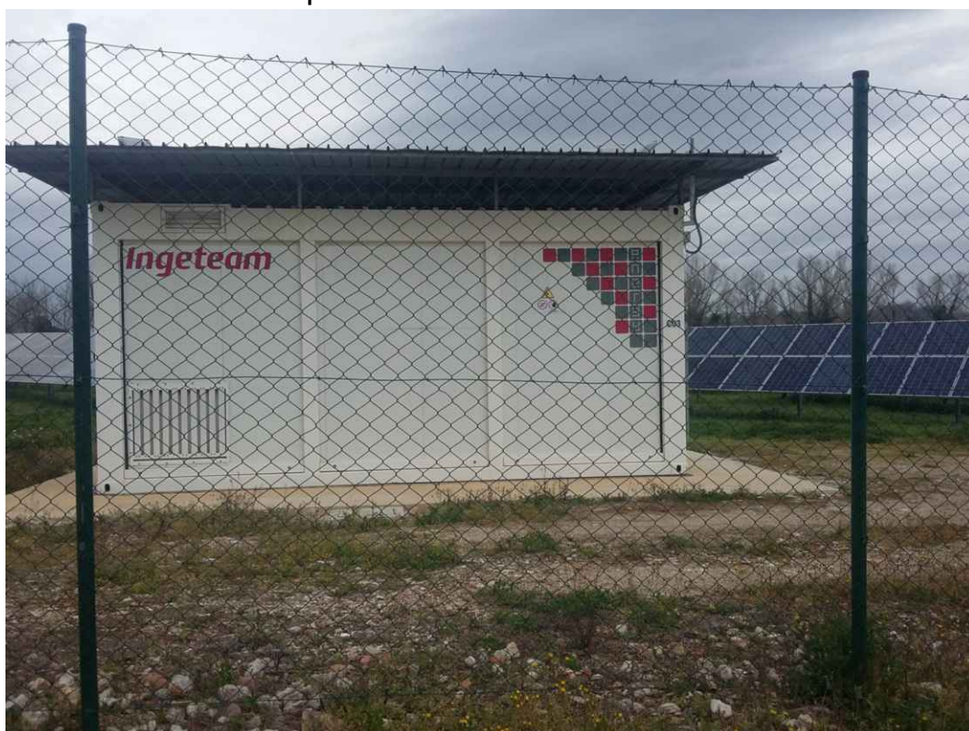
Esempio di recinzione e cabina inverter
