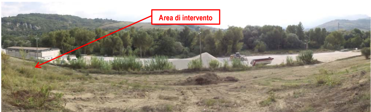
Foto 2 - Vista area d'intervento
