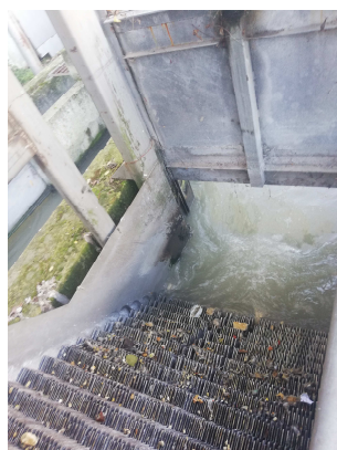
Grigliatura fine e dissabbiatura
