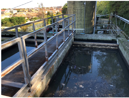
Sedimentatore primario (SED-I 1) e Letto Percolatore (PERC 1)
