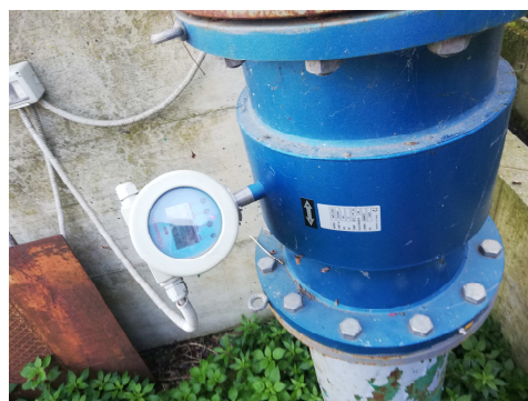
Misuratore di portata in ingresso all'impianto (acque provenienti dalla Nazionale)
