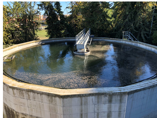
Vasca di ossidazione REA 2 e Sedimentatore secondario (a pianta circolare) SED-II 2
