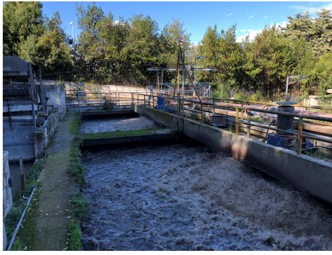
Vasca di ossidazione REA 1 e Sedimentatore secondario (a pianta circolare) SED-II 2
