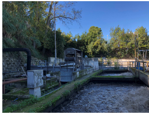
Griglia a gradini a pulizia automatica
