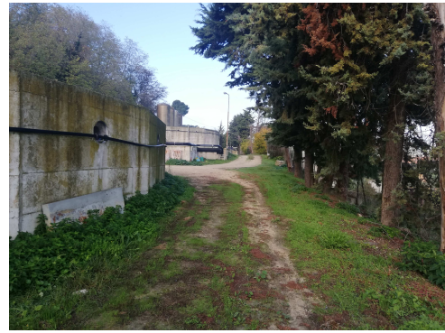
Area da impermeabilizzare (parzialmente)
