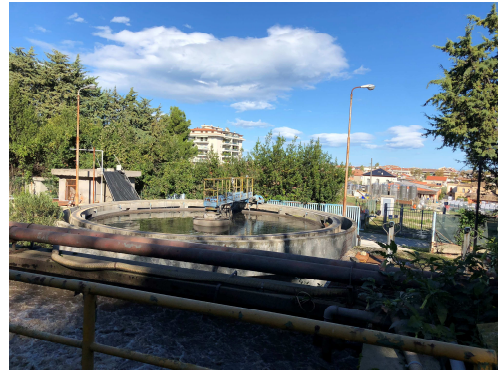
Vasca di ossidazione REA 1 e Sedimentatore secondario (a pianta circolare) SED-II 2
