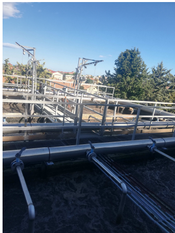
Vasca di ossidazione REA 2 e Sedimentatore secondario (a pianta circolare) SED-II 2
