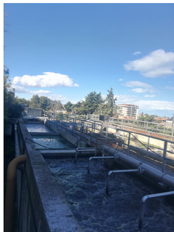
Sedimentatore primario (SED-I 2) e Letto Percolatore (PERC 2)
