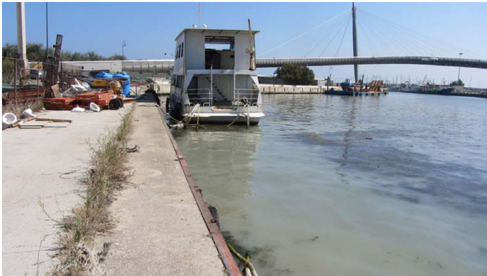
Foto 6 – Banchina a perimetro NW area d'intervento. Bassi fondali, ormeggi per disarmo
