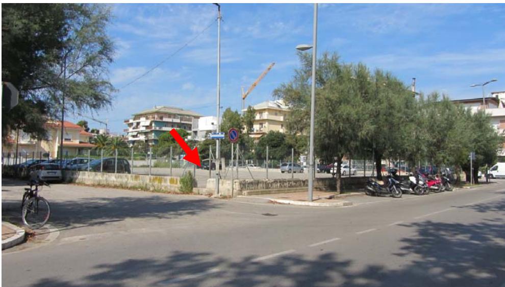
Foto 27 – Visione d'assieme della zona parcheggio, sito Vasca n° 6 (freccia)
