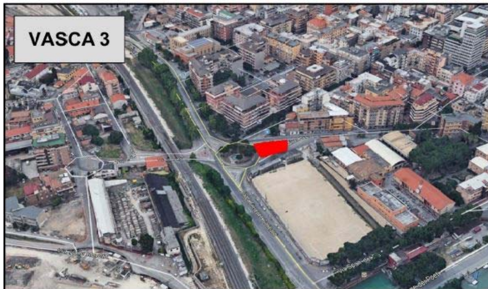
Foto 14 - Localizzazione Vasca di 1 a pioggia n° 3, Rampigna
