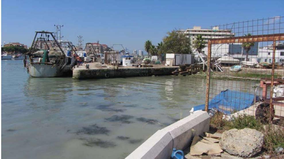
Foto 7 – A monte dell'intervento: scivolo d'alaggio e piccola darsena
