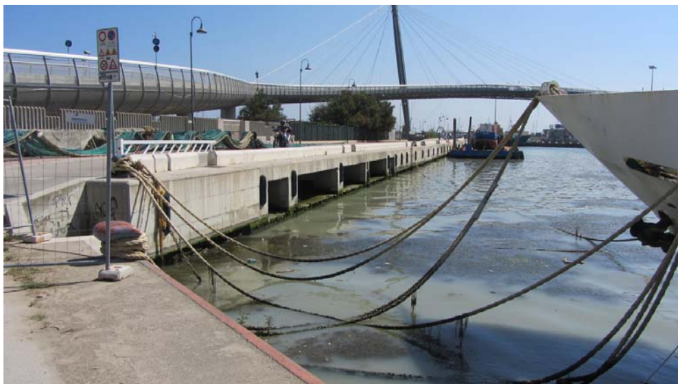
Foto 4 – Banchina a perimetro Nord dell'area d'intervento. Bassi fondali, ormeggi temporanei
