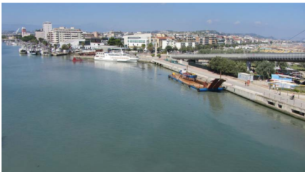
Foto 2 – Visione d'assieme del porto canale, sponda in sx idrografica, con area d'intervento
