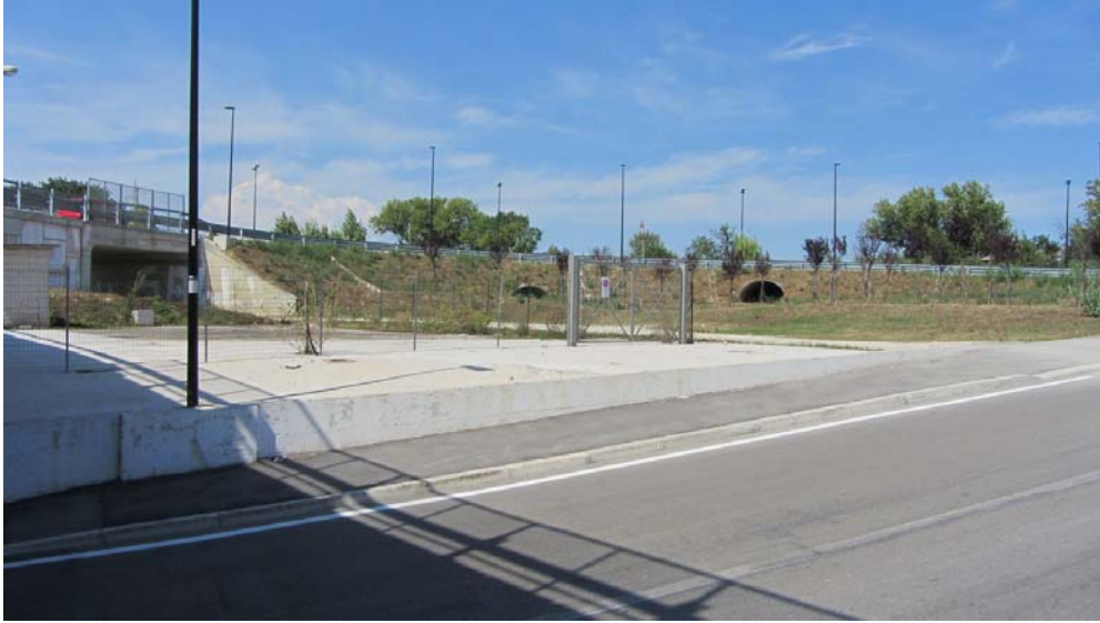
Foto 22 – Vasca 5.a . Da sx: manufatto recintato con pavimentazione, pista, tubi, sistemazioni a verde
