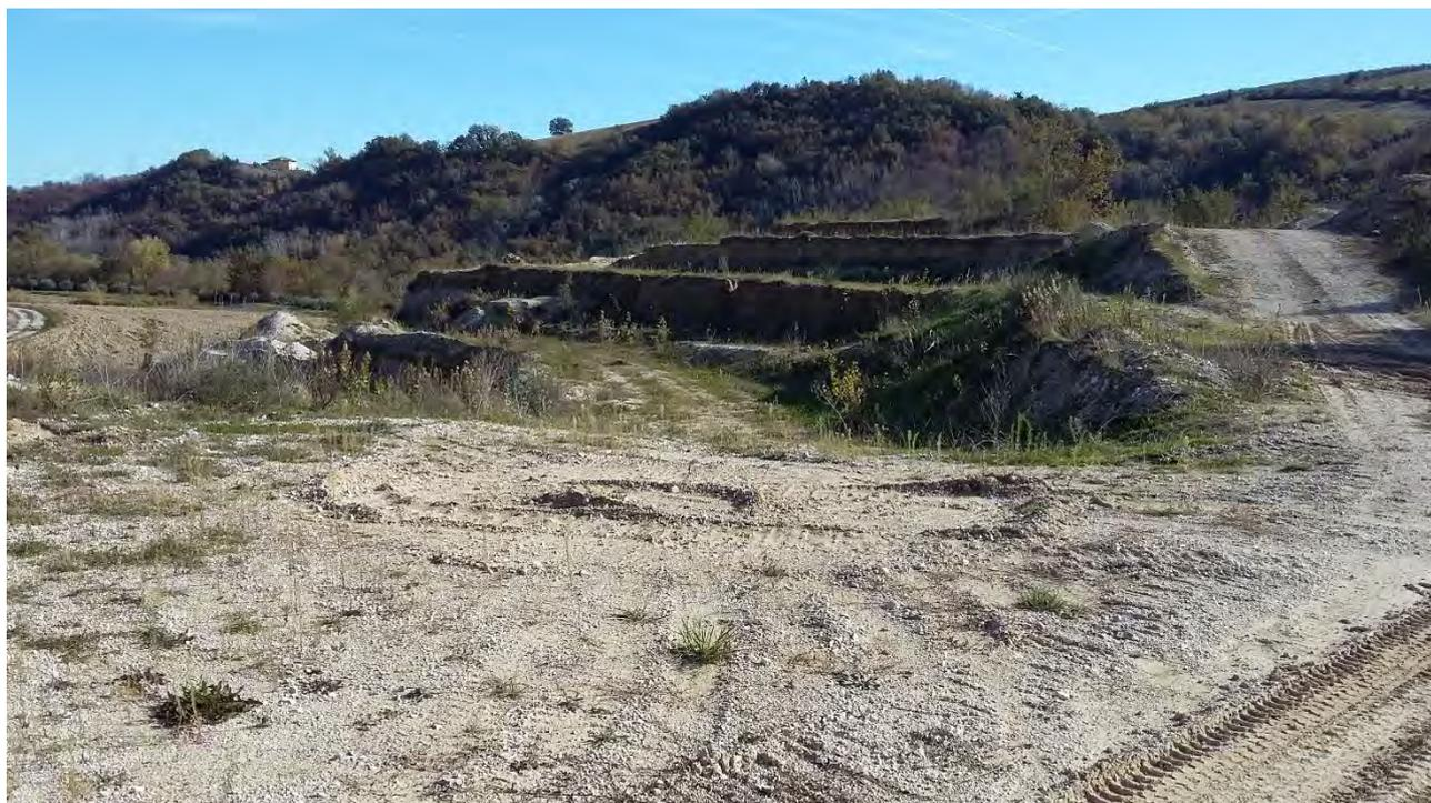
Foto 3 – Cava Samica ( Novembre '18) Dettaglio parte superiore foto 2.( fronte cava nord-est) La pista sterrata visibile è di arroccamento per le attività di scavo.
