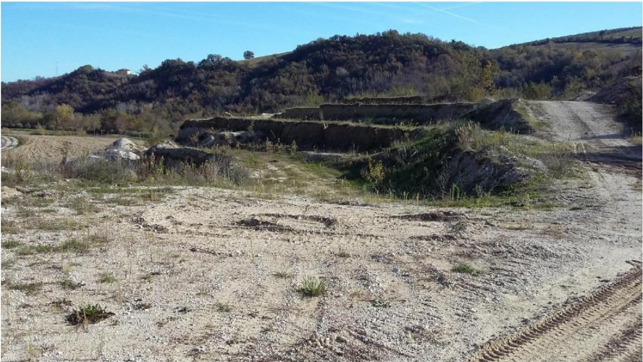
Foto 3 – Cava Samica ( Novembre 018) Dettaglio parte superiore foto 2.( fronte cava nord-est) La pista sterrata visibile è di arroccamento per le attività di scavo
