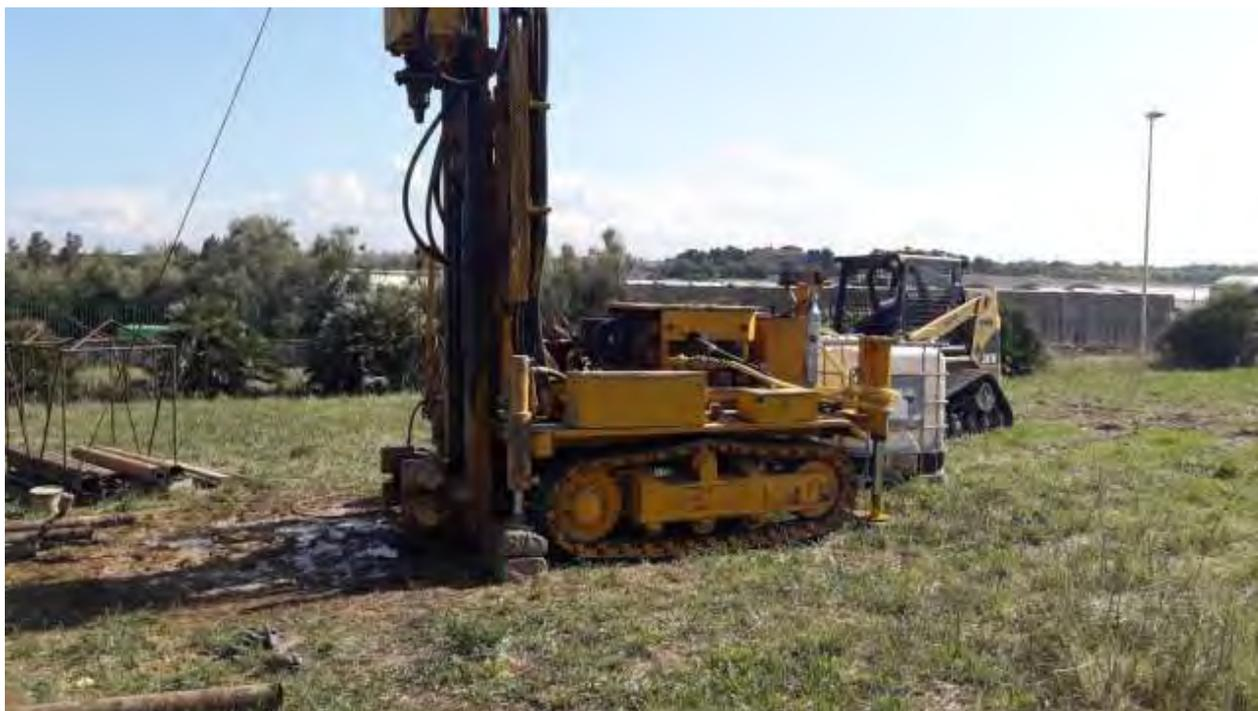
Figura 17: installazione piezometro Pz2.
