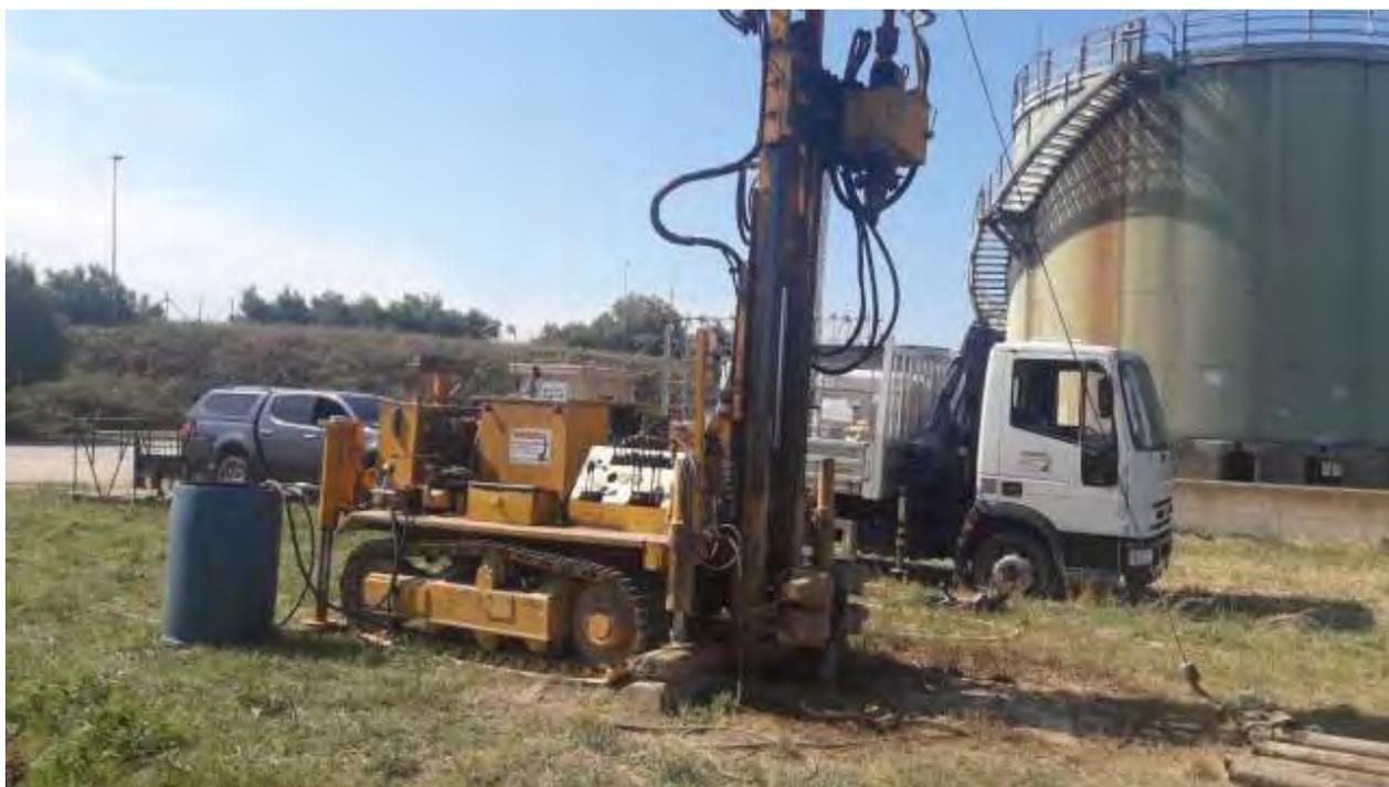
**Figura 12: installazione Piezometro PZ1.**
