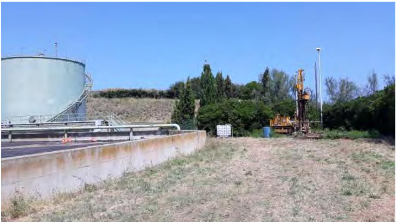
**Figura 21: installazione sondaggio e piezometro PZ3.**
