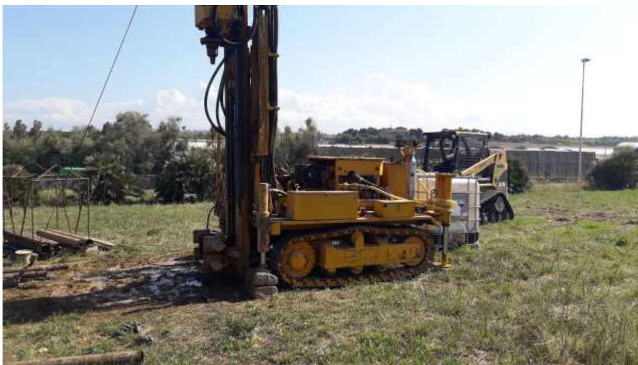
Figura 17: installazione piezometro Pz2.
