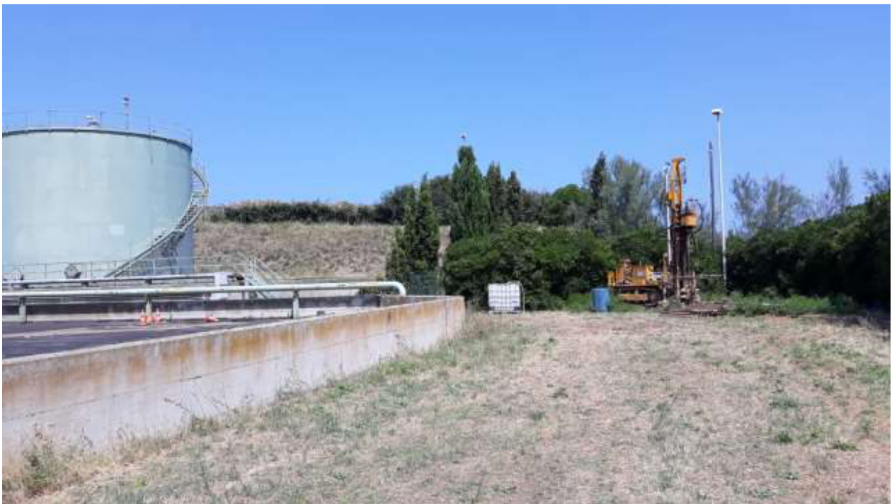
Figura 21: installazione sondaggio e piezometro PZ3.
