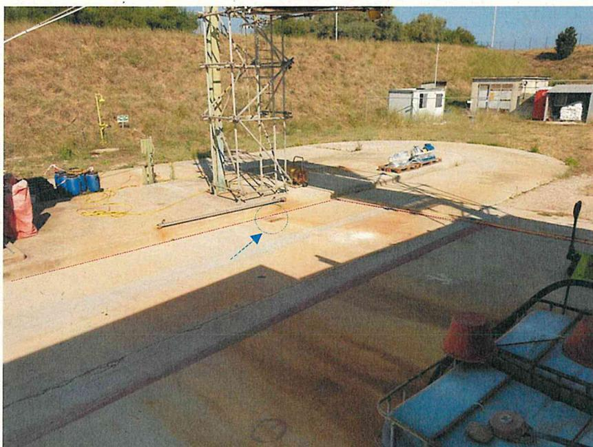
Punto di Carico A con particolare pozzetto raccolta
