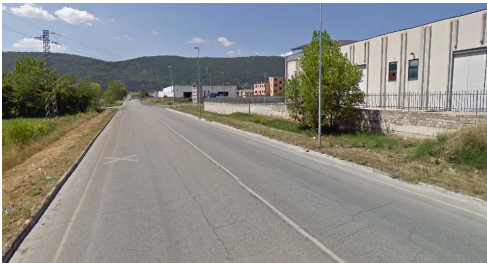
Figura 31 – immagine di repertorio della viabilità locale (Via Newton)
