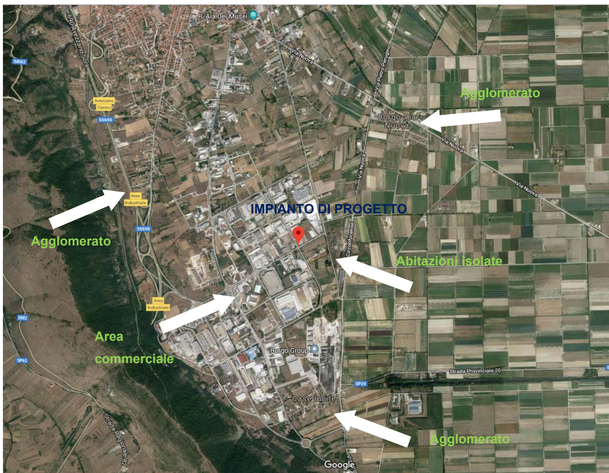
Figura 5 – vista aerea del sito e suoi dintorni.
