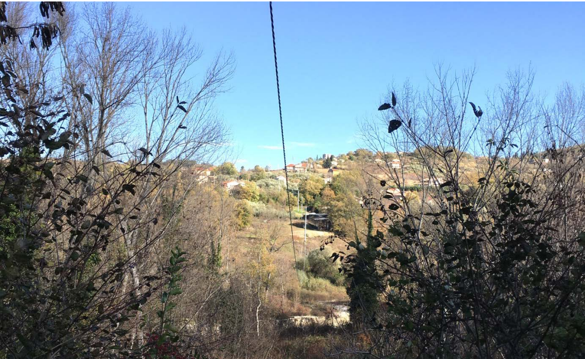
Immagine 23 – Foto attraversamento aereo Fiume Lavino (Scafa) con cavo cordato ad elica visibile. È evidente la freccia del cavo ed il taglio della vegetazione corrispondente alla fascia di servitù.
