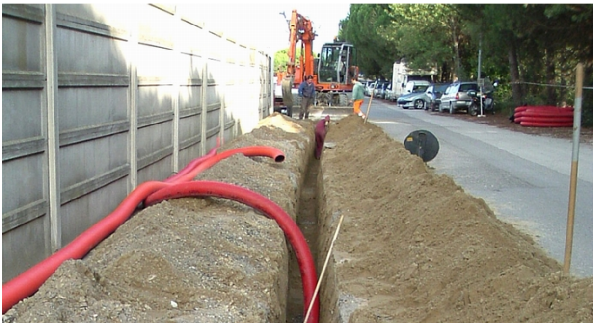
Immagine 40 – Cantiere per linea elettrica di media tensione interrata su strada asfaltata
