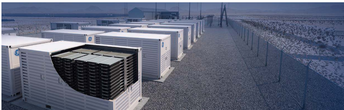
Immagine 21 – Vista delle batterie al litio alloggiare dentro apposite cabine
