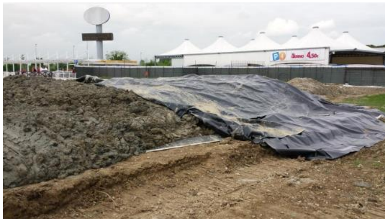
Esempio di copertura dei cumuli di materiale stoccato Fonte delle immagini: Progettare secondo criteri di sostenibilità ambientale: protocolli di certificazione e Green Public Procurement - Venezia 26 maggio 2017
