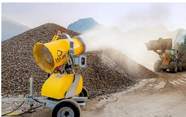
Esempio di Irrorazione delle aree di cantiere
