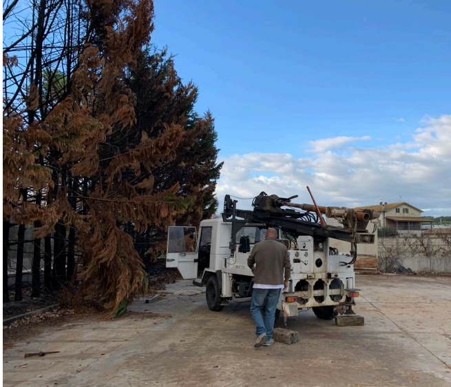
Foto n. 1: fase realizzazione sondaggio S1
