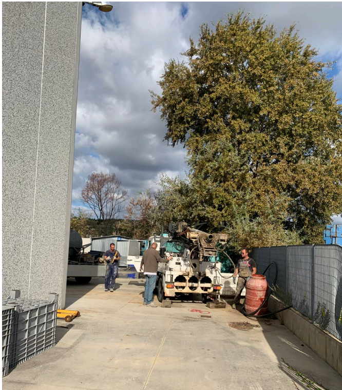
Foto n. 2: fase realizzazione sondaggio S3
