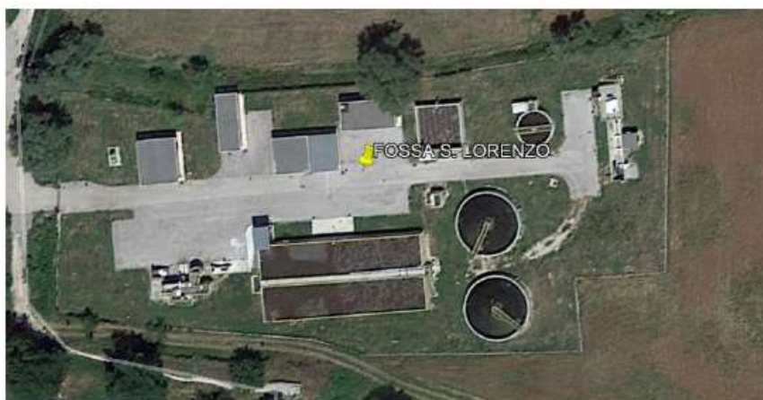
Figura 1: Immagine aerea del depuratore di Fossa San Lorenzo prima degli interventi di impermeabilizzazione delle vasche e delle aree di transito mezzi
