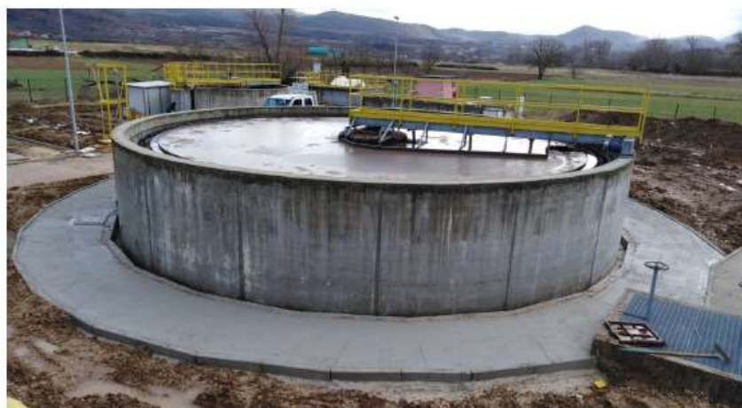
Figure 3 e 4: Avanzamento lavori impermeabilizzazione area sedimentatori
