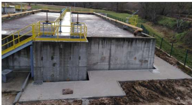
Figure 5 e 6: Avanzamento lavori impermeabilizzazione area vasche di ossidazione
