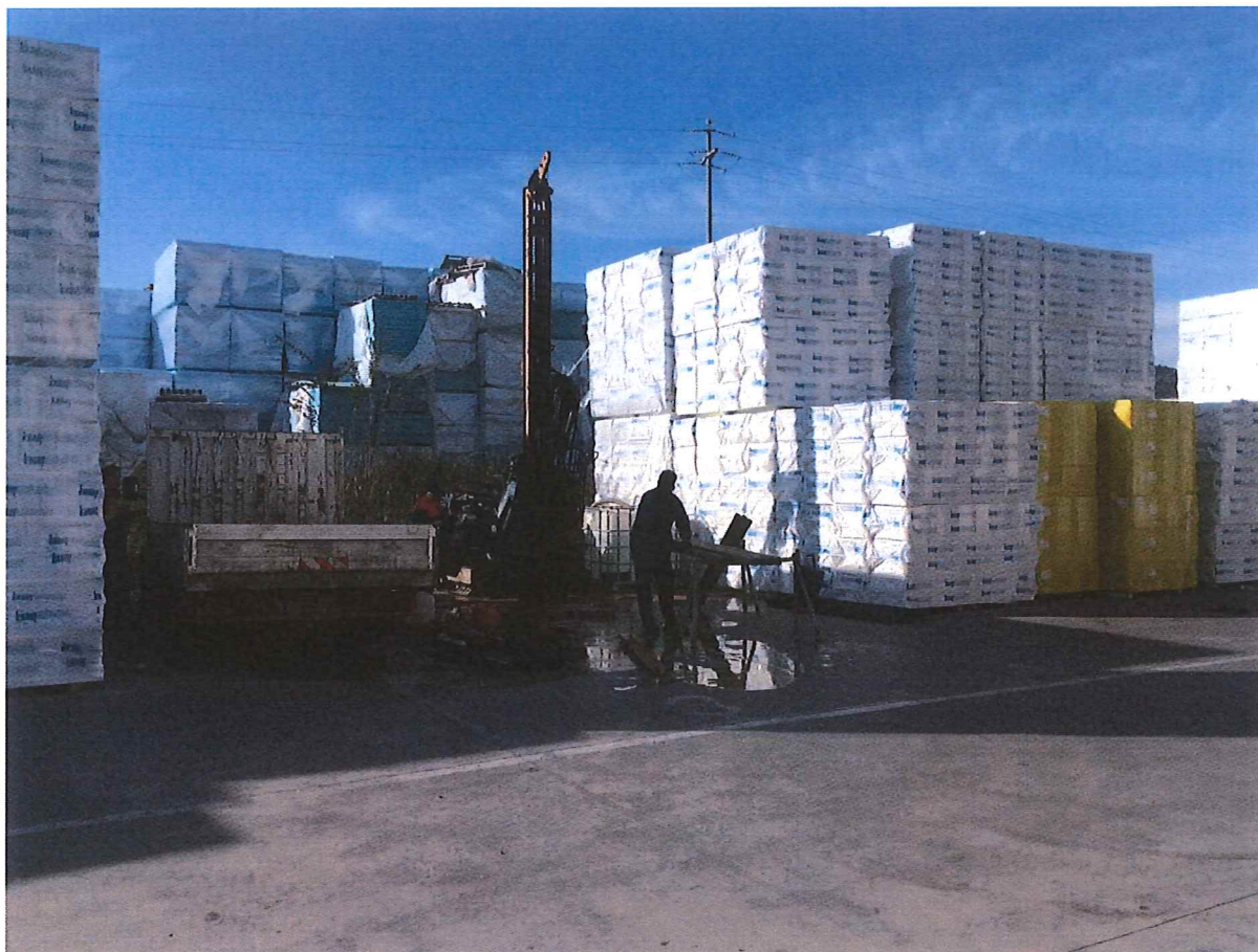
Postazione Sondaggio S1 strumentato con piezometro a t.a. (29.10.2019)
