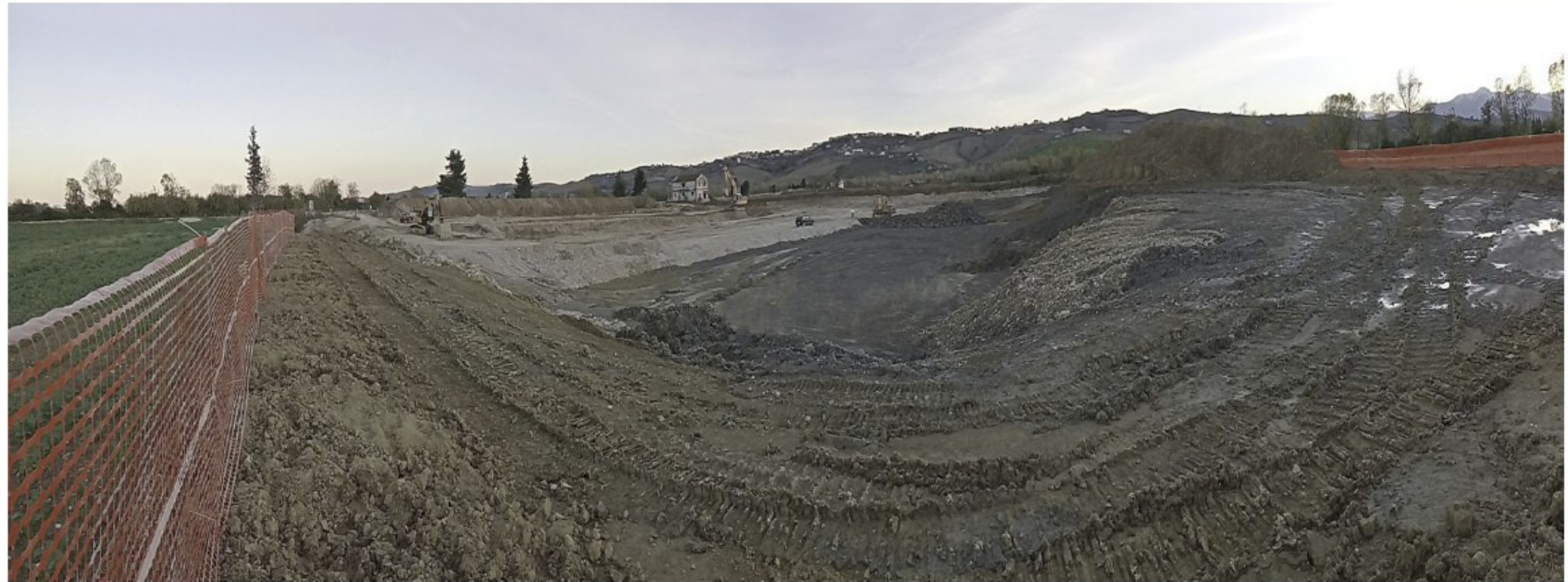
fig. 6: documentazione fotografica dello stato di fatto dei luoghi con recupero del piano di fondo assentito e ripristino della recinzione
