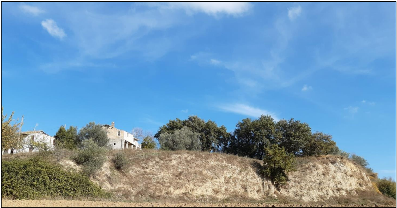
Figura 12: Fronte di scavo pericoloso a ridosso di abitazione.
