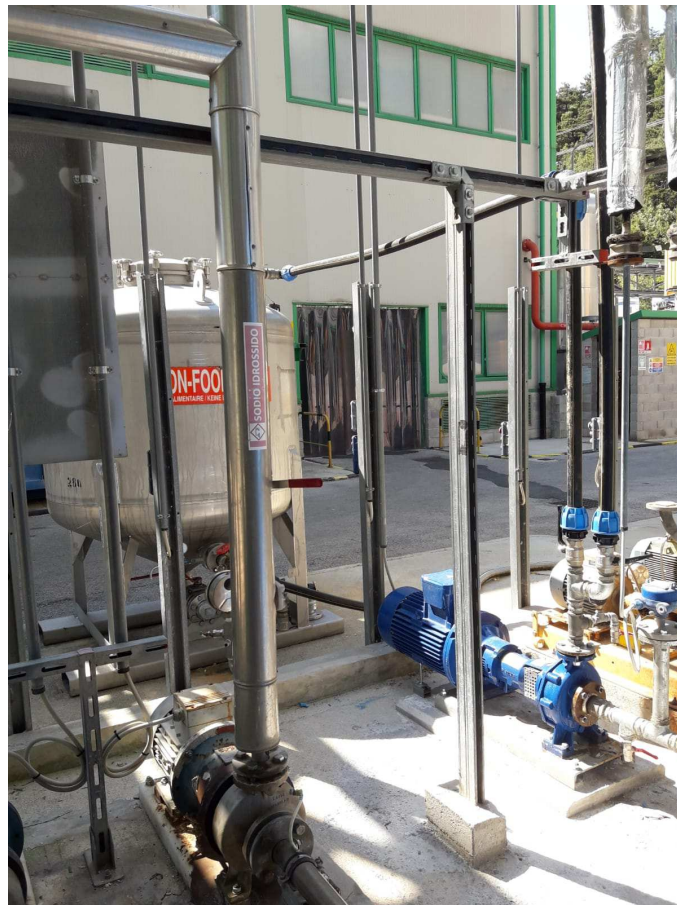
Fig. 2.2.5: vista d'insieme del filtro, della pompa e delle linee di ingresso ed uscita
