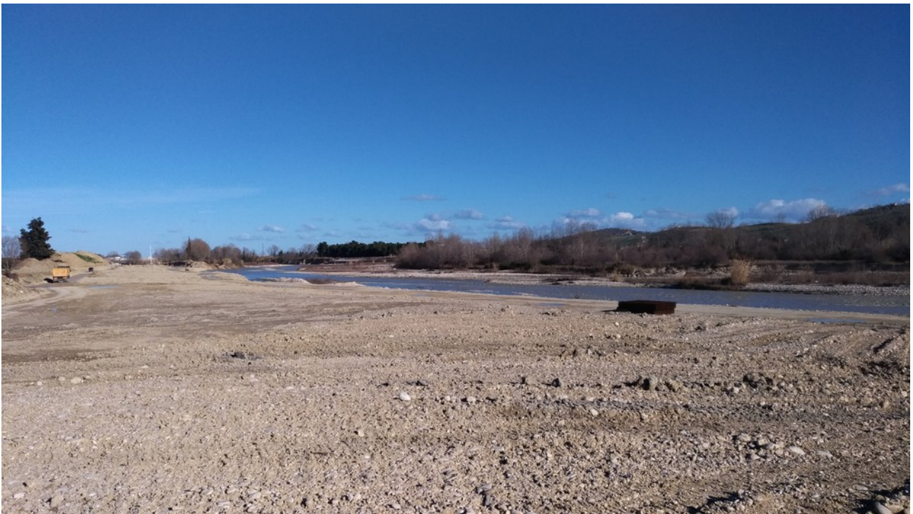
Visione del cantiere verso il fiume all'altezza della sezione 2, lato nord (sinistra idrografica). Si noti il camion per dare conto delle dimensioni (dichiarate di poco meno di 20 metri nella sezione).
