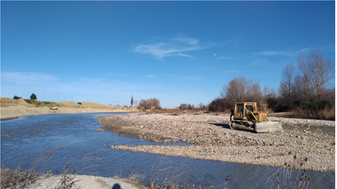
Mezzo di cantiere sul greto del fiume, lato sud (06/08/2020). In uno dei video allegati passerà in alveo.
