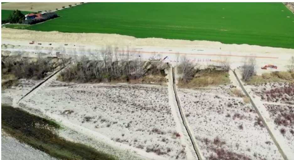
Fotogramma del video del 16/02/2020. Scavi per tre canali (dreni?). Si noti che quello a valle compare dopo il rilievo dell'08/02/2020 (si veda la foto successiva con i due tratti di canale).
