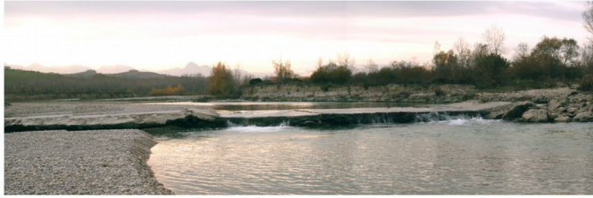
Punto visuale n. 3 - Vista dalla briglia esistente e dell'argine sinistro
