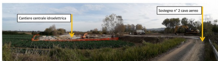
Immagine 32 - Cantiere centrale idroelettrica. Foto del 27.11.2019
