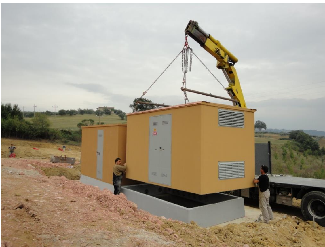
Installazione cabine elettriche prefabbricate
