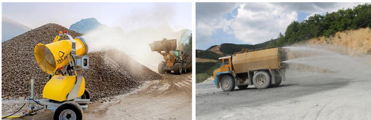
Esempio di Irrorazione delle aree di cantiere
