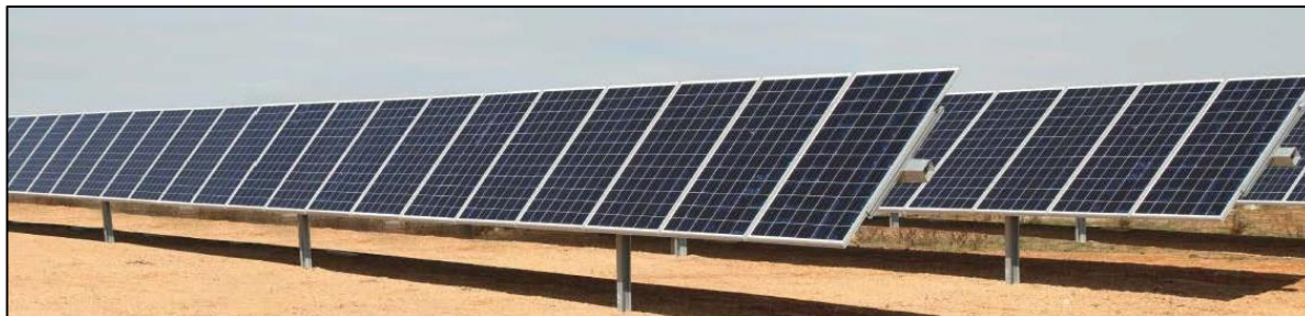
Esempio di sistema ad inseguimento Fonte delle immagini: soltigua.com
