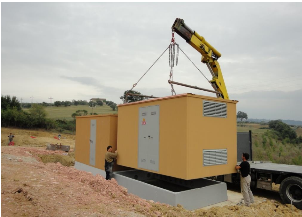
Installazione cabine elettriche prefabbricate
