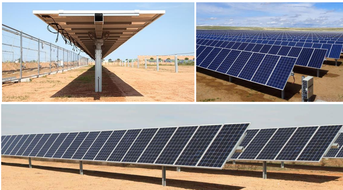
Particolare inseguitore monoassiale est-ovest
